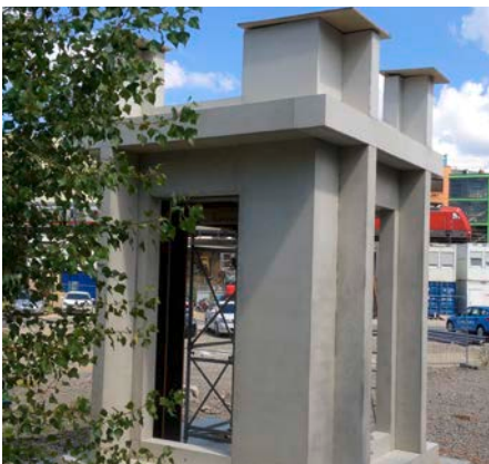
(5) Beispiel für eine konventionelle SB 4-Vorbereitung: Farbtonauswahl am Mock up
