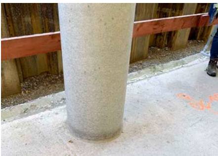
(9) Sockel einer 12 m hohen Sichtbetonstütze
