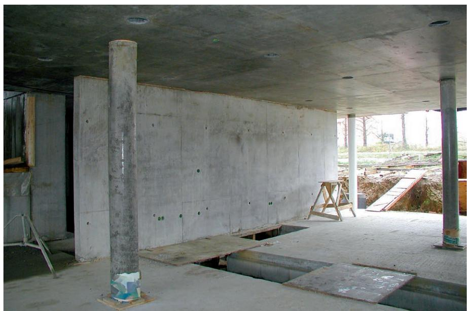
(5) Signifikante Farbtonabweichungen können durch ein Betonieren in der nassen und kalten Jahreszeit entstehen.
