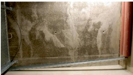
(6) Farbtonunterschiede bei Betonieren bei niedrigen Außentemperaturen, hoher Luftfeuchtigkeit und langer Schalungszeit.
