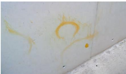
(7) Gelbverfärbung durch Kondenswasserbildung bei Phenolharzschalung.
