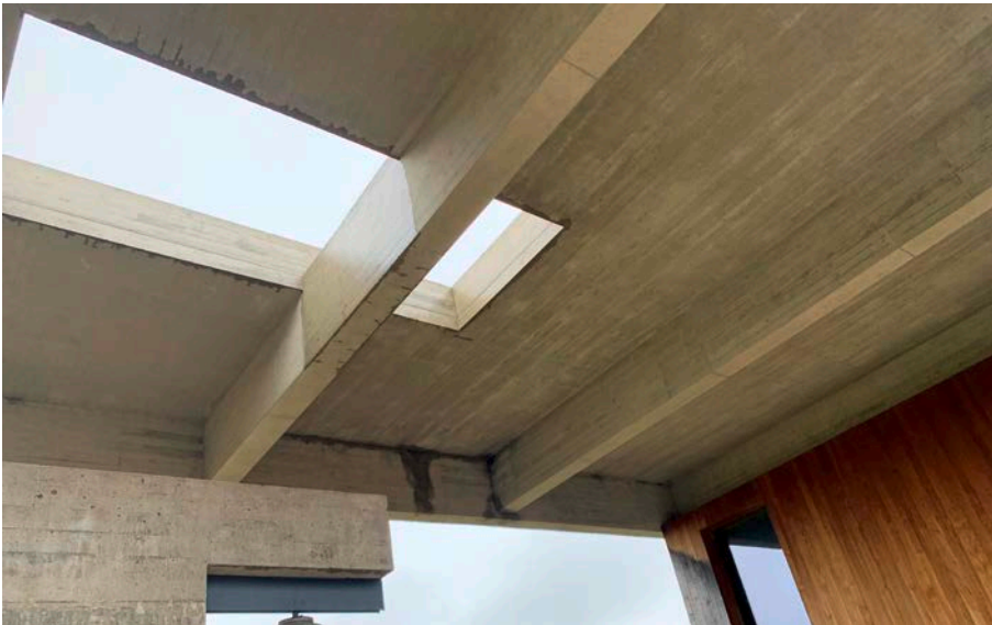
(9) Gereinigte Flächen, Bereiche mit Wasserdurchtritt am Flachdach
