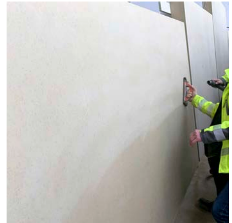
(8) Abschleifen von Oberflächen
